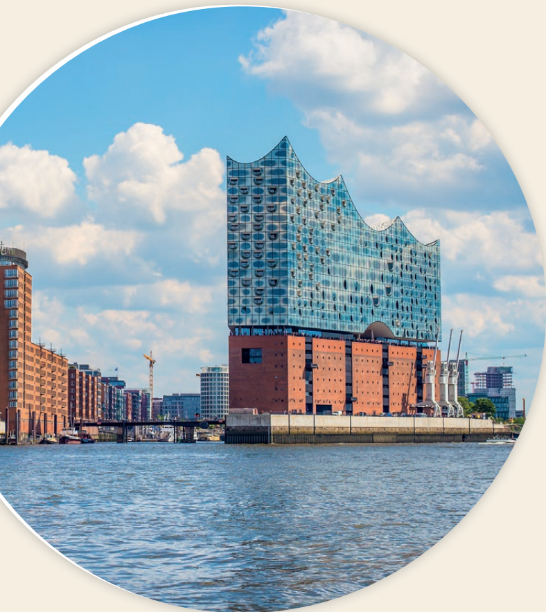
Die beeindruckende Fassade der Elbphilharmonie besteht aus 1.100 individuell gebogenen Glaselementen.
